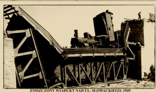
ZNISZCZONY WIADUKT NAD UL. SŁOWACKIEGO, 1945
